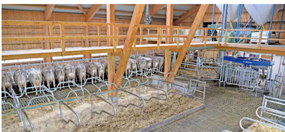
La nuova stalla a stabulazione libera con sistema di mungitura automatica è stata terminata nel 2020.
